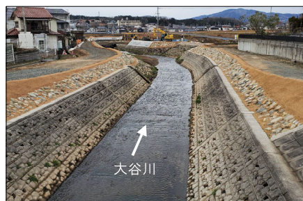
広島県による支川の改修 大谷川
