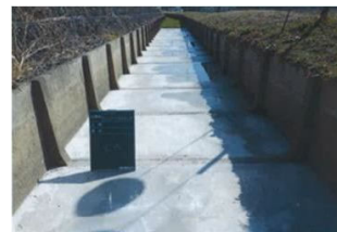
底張コンクリート
