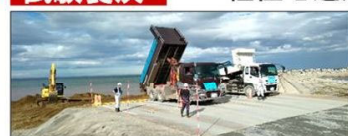
養浜材の荷下・投入状況 (R4.8.18 撮影)
