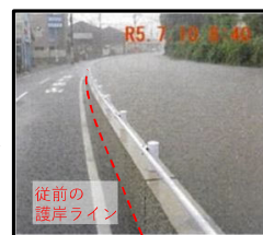
<池町川護岸嵩上げ>
