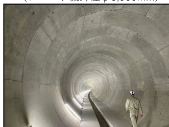
雨水貯留管内部 (仕上がり内径φ5,250mm)
