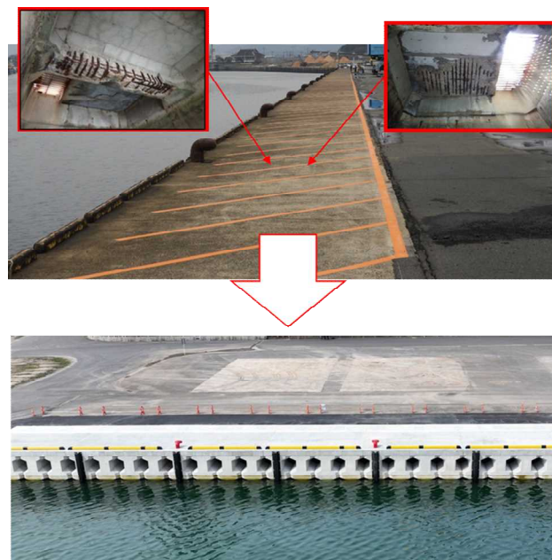
写真-3 老朽化対策を行っている妙見3号岸壁
