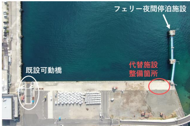
写真-4 代替施設整備箇所
