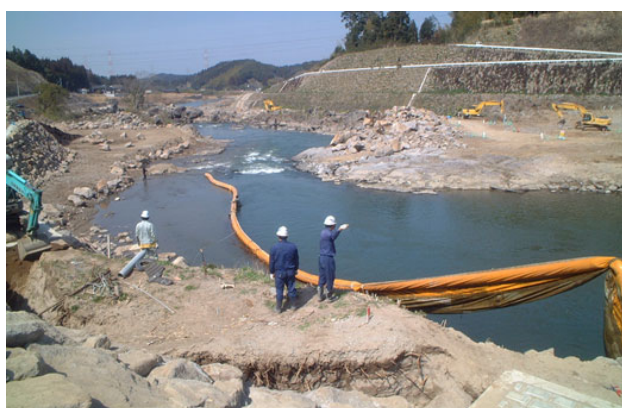
(写真-2) 狭窄部の開削工事
