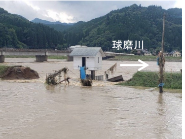
▲球磨川56.4kの堤防決壊状況(人吉市)
