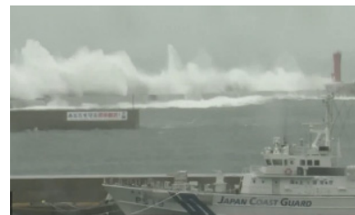
厳原地区 防波堤(北)
