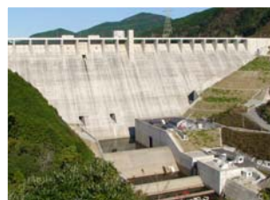
【嘉瀬川ダム完成】
