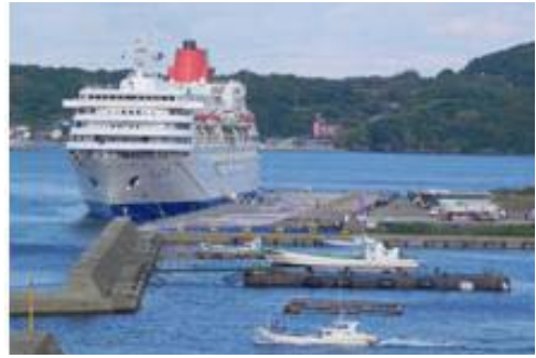
【郷ノ浦港の耐震強化岸壁(長崎県壱岐市)】
