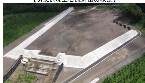
【緊急的な土石流対策の状況】
