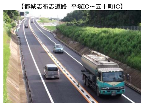
提供）九州地方整備局
