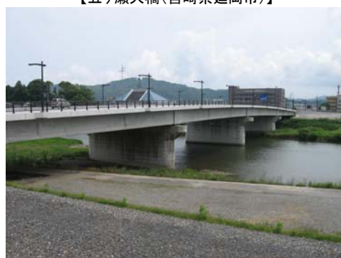
【五ヶ瀬大橋(宮崎県延岡市)】
