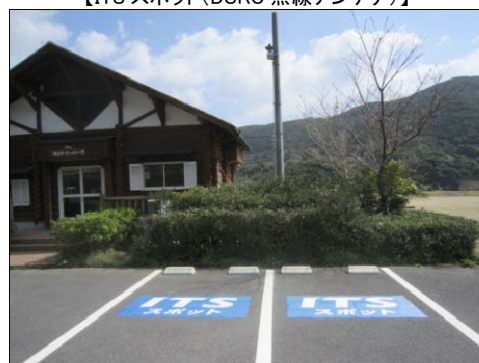
【ITSスポット(DSRC無線アンテナ)】
