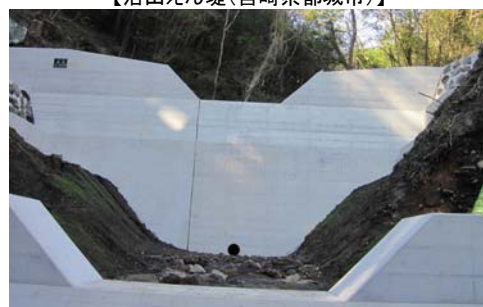
【治山えん堤（宮崎県都城市）】
