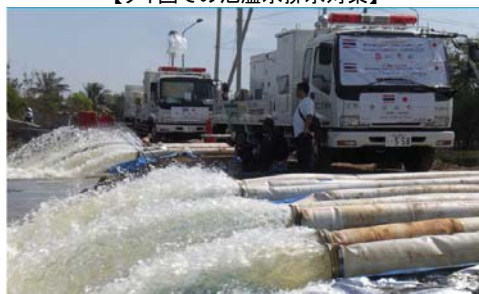
【タイ国での氾濫水排水対策】
