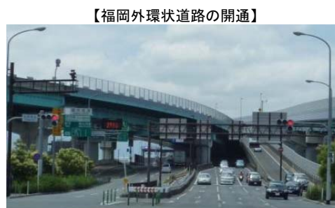
提供）九州地方整備局
