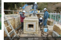
復旧工事の様子 を町HPで紹介
