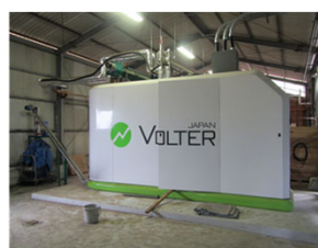
小型木材 バイオマス発電「Volter」
