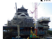
復旧工事の様子 (2018年10月)
