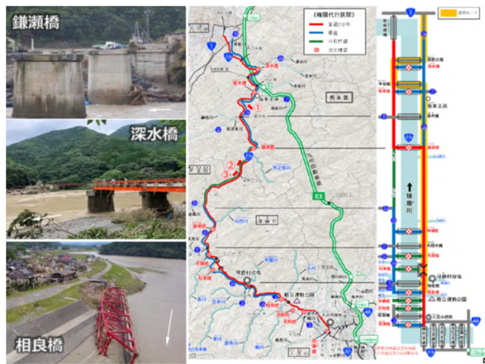
球磨川で道路橋10橋が流失
