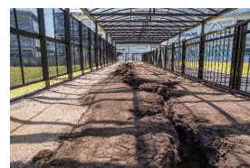
地表地震断層
