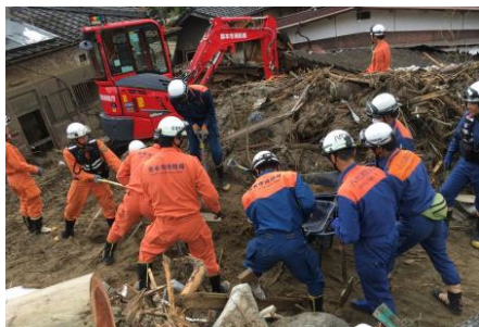
瓦礫・土砂の除去作業支援
