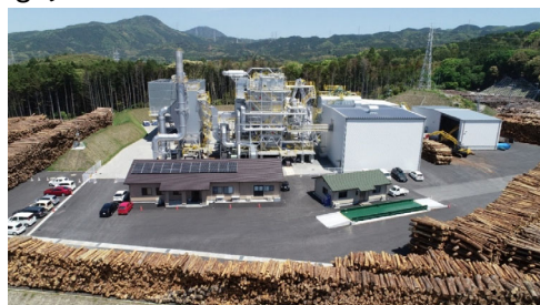
ふくおか木質バイオマス発電所 (2020/5/20運転開始)
