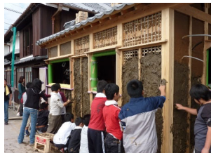
地元小学生による土塀塗り体験
