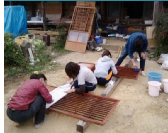
地域おこし協力隊員による古民家修復作業(事例)
