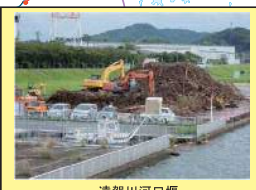
遠賀川河口堰 ゴミの陸揚げ状況
