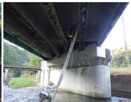
ハシゴによる橋梁点検状況
