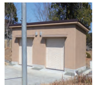
防災用備蓄倉庫
