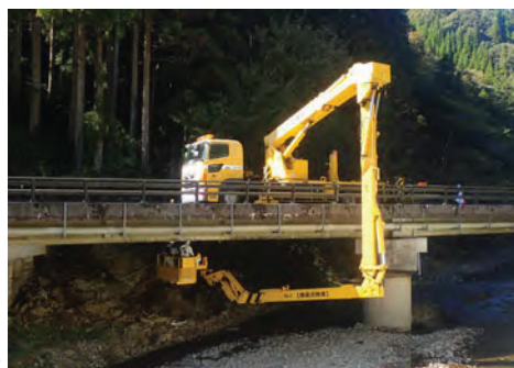
橋梁点検車による点検状況
