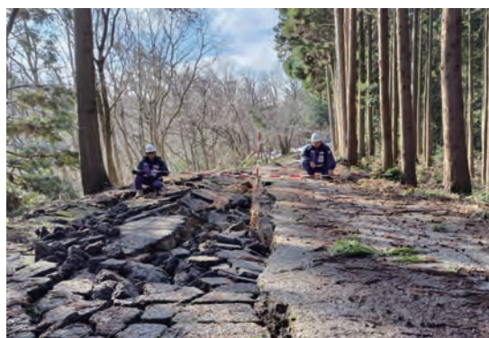
調査状況(石川県輪島市)
