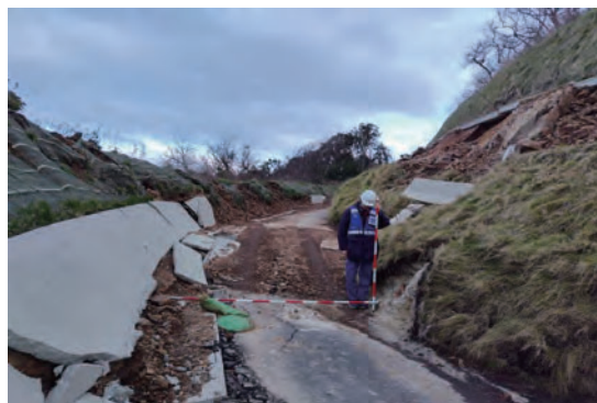
調査状況(石川県輪島市)
