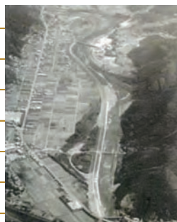
●井崎川捷水路工事/昭和54年度
