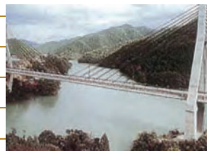
●一般国道326号頃んか大橋(施工後)/平成5年度
